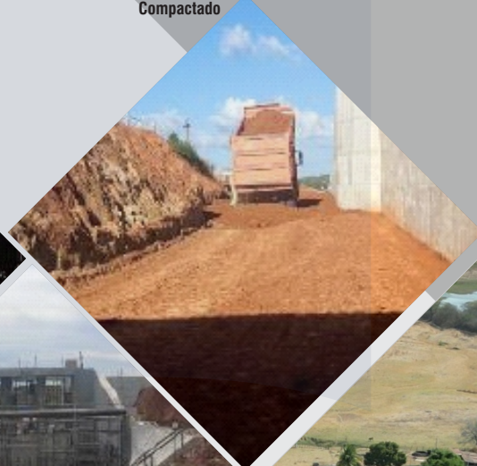
Execução de Aterro Compactado
