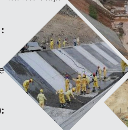
Execução de Geomembrana e placas de proteção
