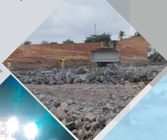
Execução de enrocamento compactado
