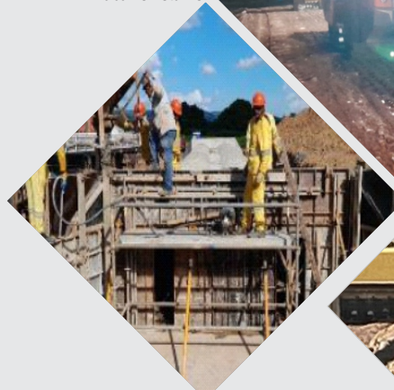
Execução de Bueiro
