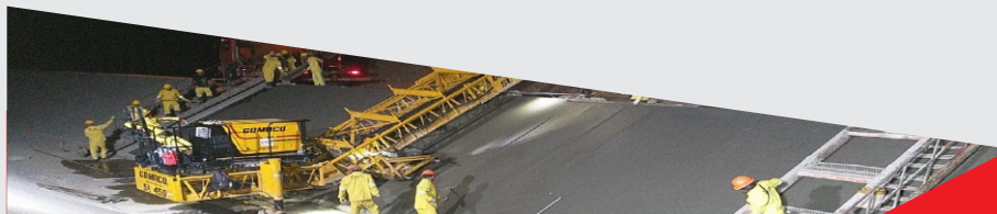
Execução de Placas de Concreto (Noturno)
