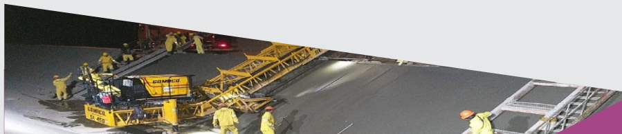
Execução de Placas de Concreto (Noturno)
