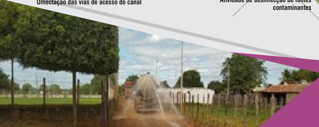
Umectação das vias de acesso do canal
