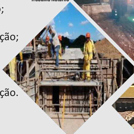
Execução de Bueiro
