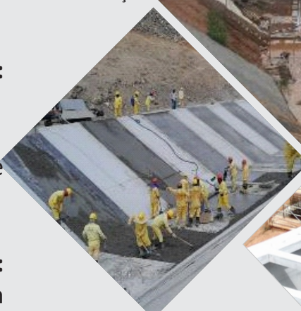
Execução de Geomembrana e placas de proteção
