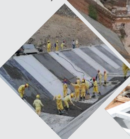
Execução de Geomembrana e placas de proteção
