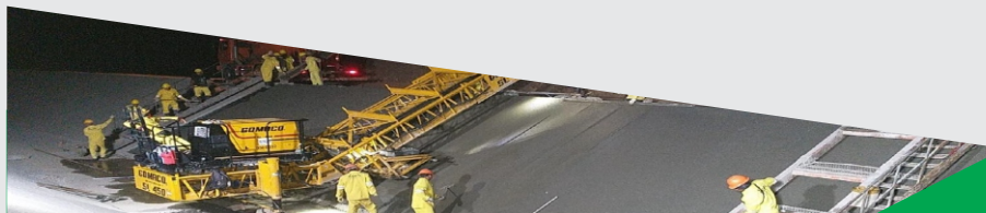
Execução de Placas de Concreto (Noturno)
