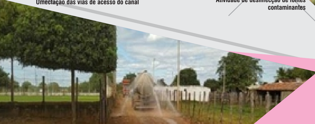
Umectação das vias de acesso do canal
