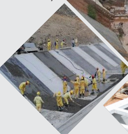
Execução de Geomembrana e placas de proteção
