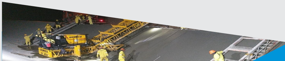
Execução de Placas de Concreto (Noturno)
