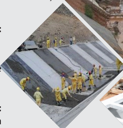
Execução de Geomembrana e placas de proteção
