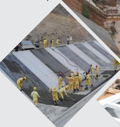
Execução de Geomembrana e placas de proteção
