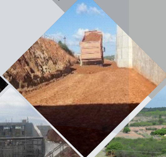
Execução de Aterro Compactado
