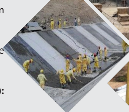
Execução de Geomembrana e placas de proteção
