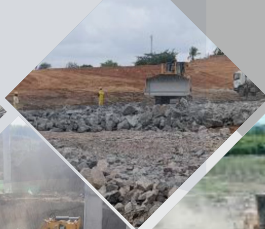
Execução de enrocamento compactado
