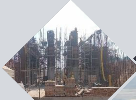
Execução de forma de armação
