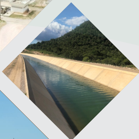
Segmento de Canal
