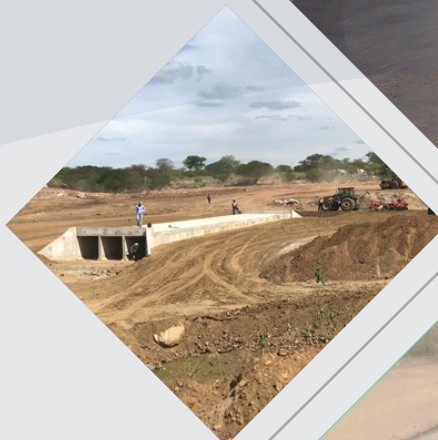
Execução de Bueiro
