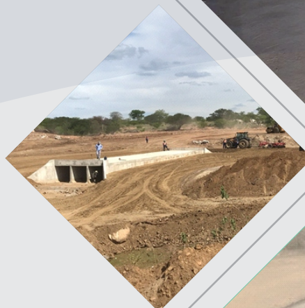
Execução de Bueiro
