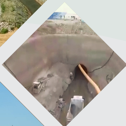
Emboque do Túnel Ipojuca
