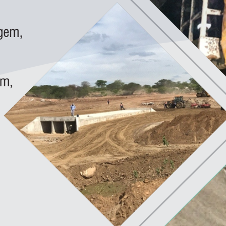
Execução de Bueiro
