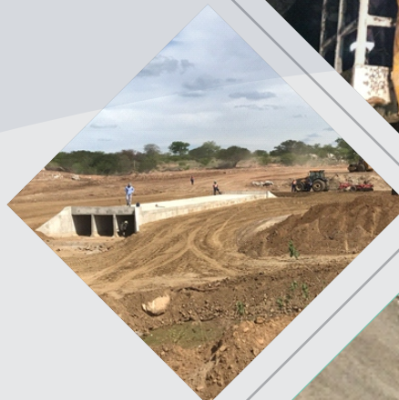
Execução de Bueiro
