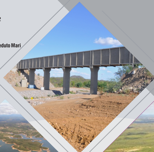
Estação de Bombeamento EBI-2
