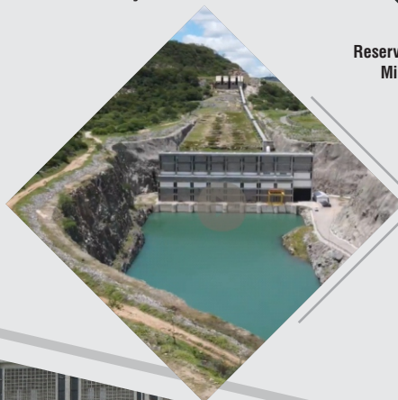
Estação de Bombeamento EBI-3
