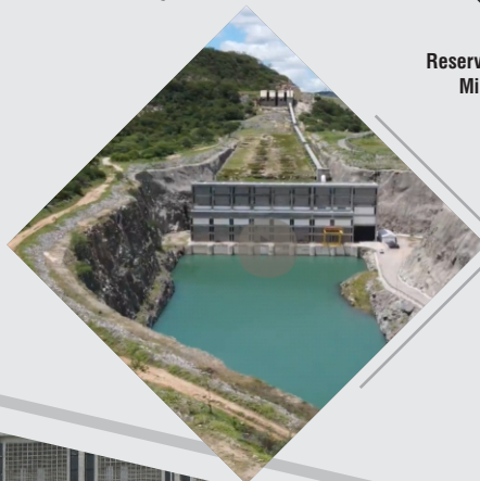
Estação de Bombeamento EBI-3
