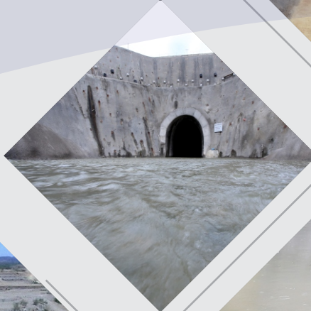
Túnel Eng. Giancarlo Lins Cavalcanti - Emboque
