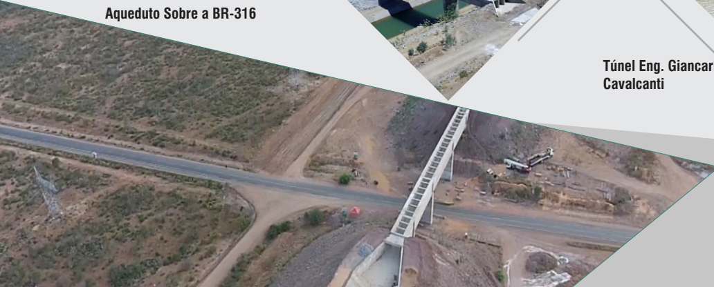
Aqueduto Sobre a BR-316
