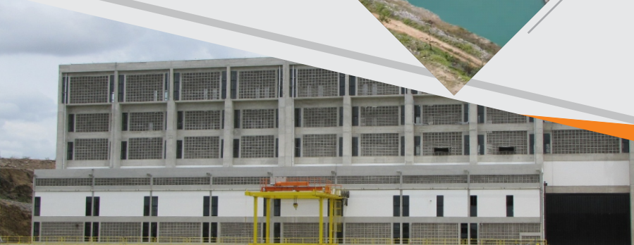
Estação de Bombeamento EBI-1
