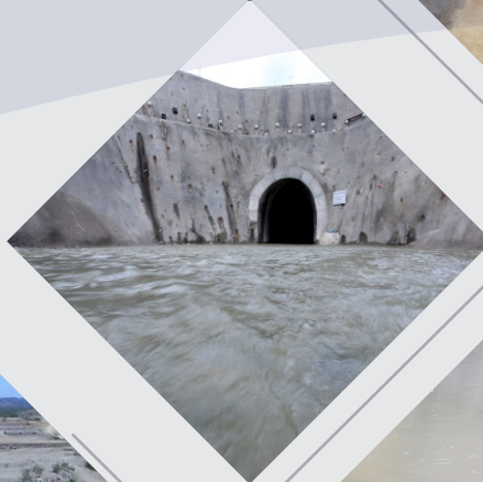
Túnel Eng. Giancarlo Lins Cavalcanti - Emboque
