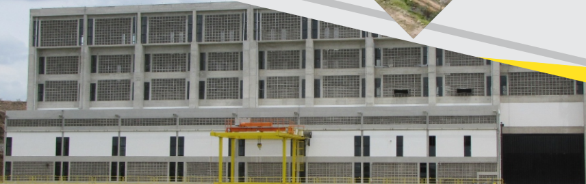
Estação de Bombeamento EBI-1
