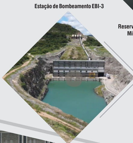
Estação de Bombeamento EBI-3
