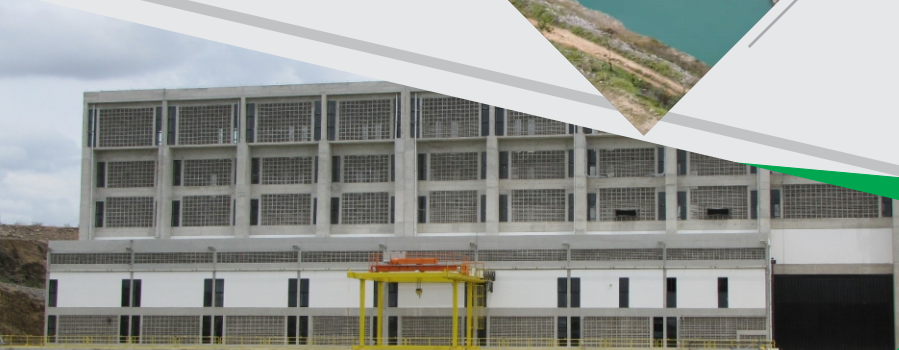
Estação de Bombeamento EBI-1
