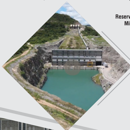
Estação de Bombeamento EBI-3
