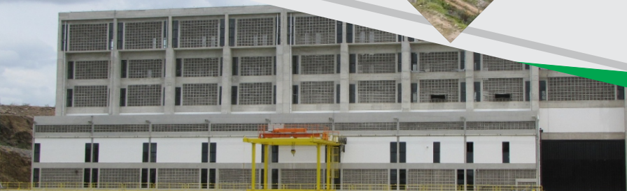
Estação de Bombeamento EBI-1
