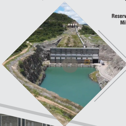
Estação de Bombeamento EBI-3
