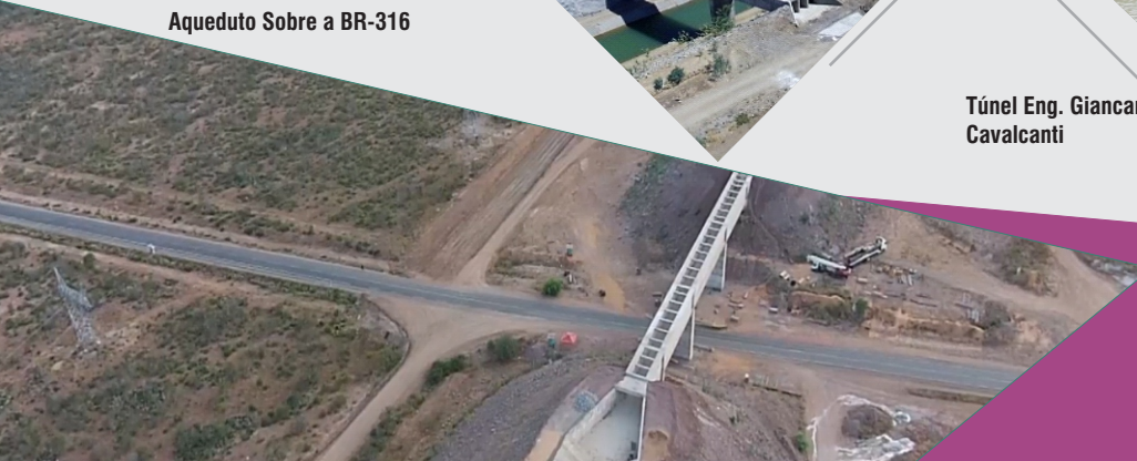
Aqueduto Sobre a BR-316
