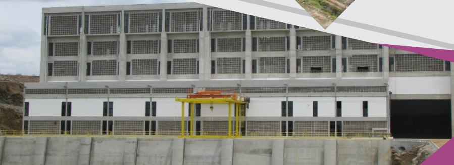
Estação de Bombeamento EBI-1
