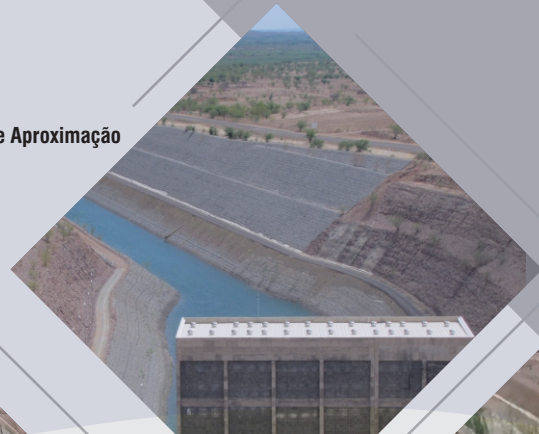
Forebay de Jusante EBV-1
