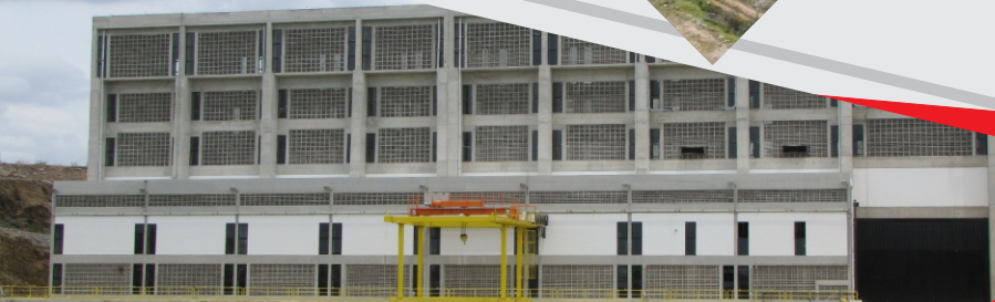
Estação de Bombeamento EBI-1
