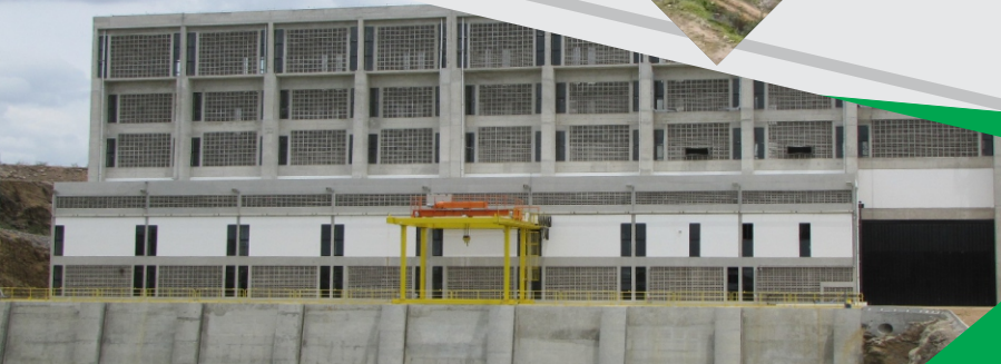
Estação de Bombeamento EBI-1
