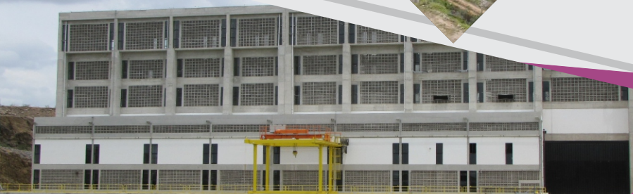
Estação de Bombeamento EBI-1
