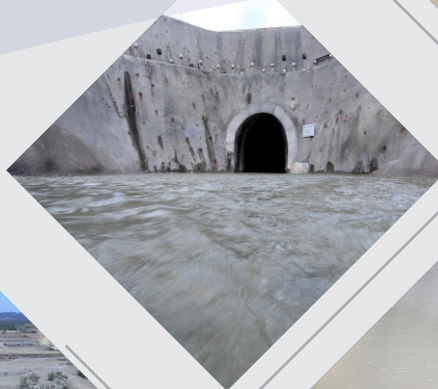
Túnel Eng. Giancarlo Lins Cavalcanti - Emboque
