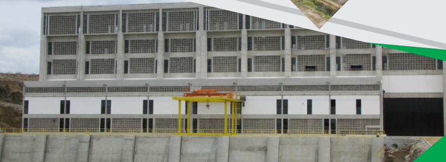
Estação de Bombeamento EBI-1
