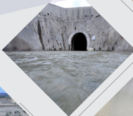
Túnel Eng. Giancarlo Lins Cavalcanti - Emboque
