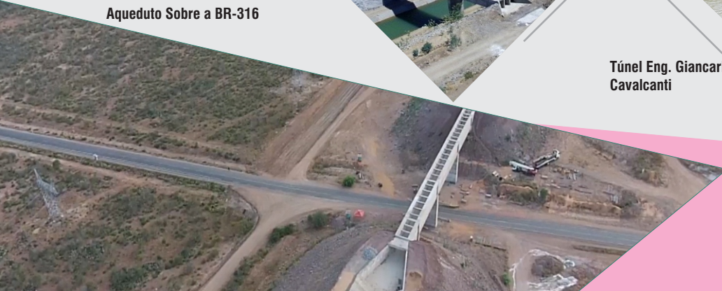
Aqueduto Sobre a BR-316
