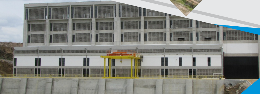
Estação de Bombeamento EBI-1
