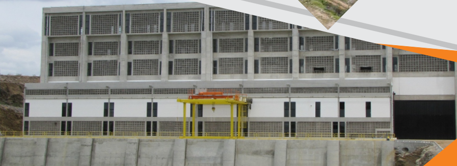
Estação de Bombeamento EBI-1
