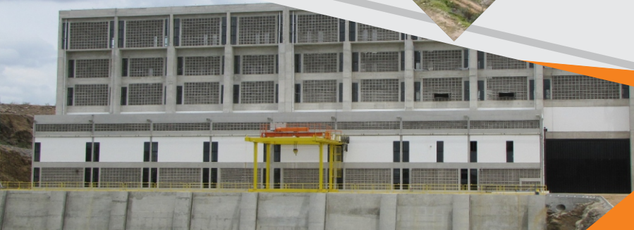
Estação de Bombeamento EBI-1
