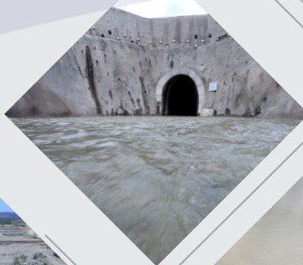
Túnel Eng. Giancarlo Lins Cavalcanti - Emboque
