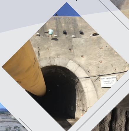
Túnel Eng. Giancarlo Lins Cavalcanti - Emboque
