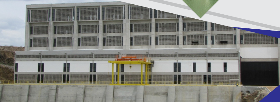
Estação de Bombeamento EBI-1
