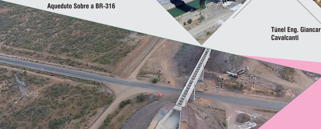
Aqueduto Sobre a BR-316
