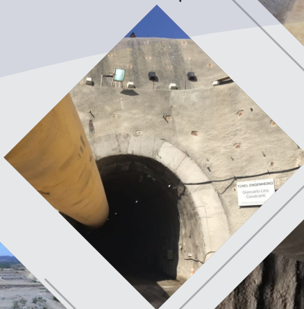
Túnel Eng. Giancarlo Lins Cavalcanti - Emboque
