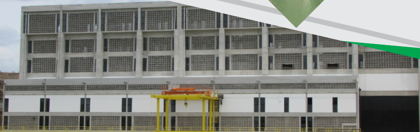
Estação de Bombeamento EBI-1
