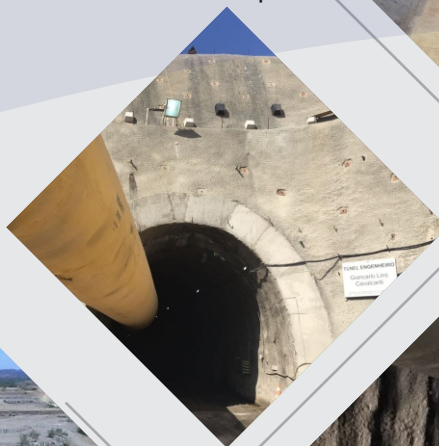
Túnel Eng. Giancarlo Lins Cavalcanti - Emboque
