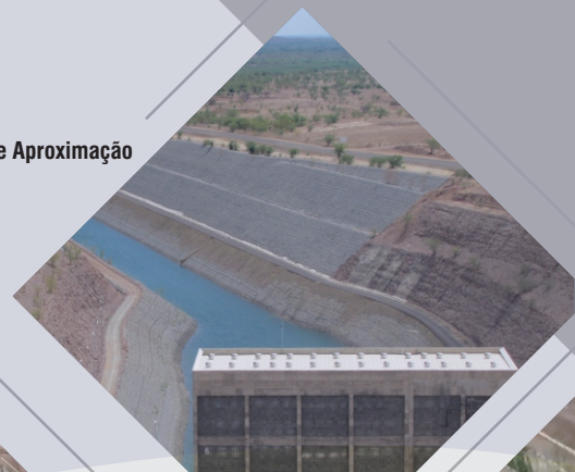
Forebay de Jusante EBV-1
