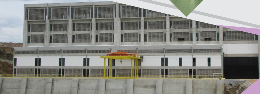
Estação de Bombeamento EBI-1
