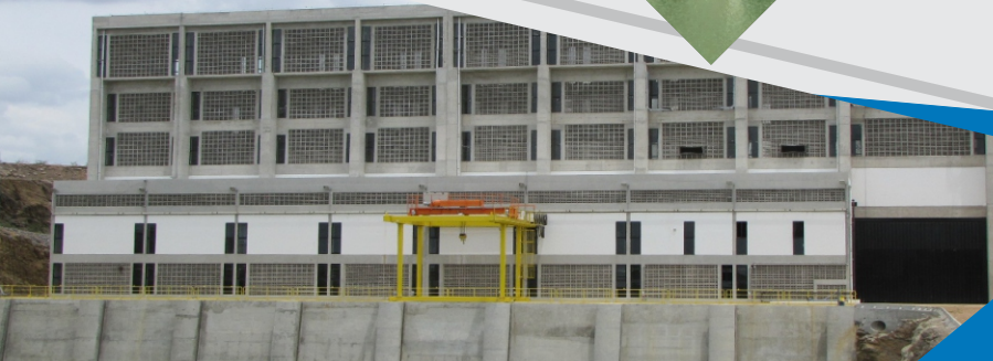
Estação de Bombeamento EBI-1
