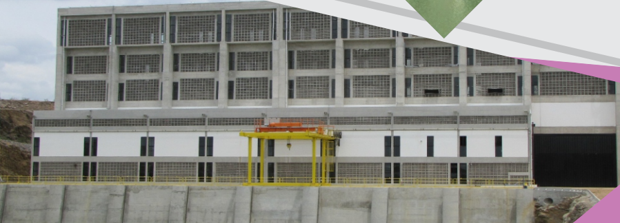
Estação de Bombeamento EBI-1
