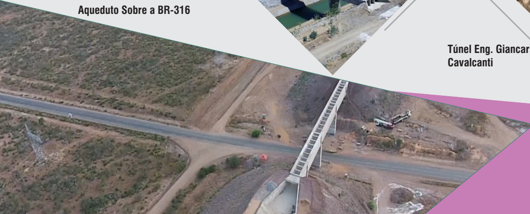
Aqueduto Sobre a BR-316
