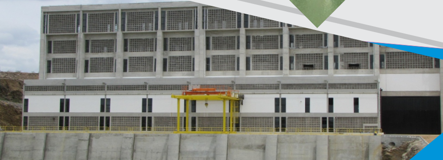
Estação de Bombeamento EBI-1
