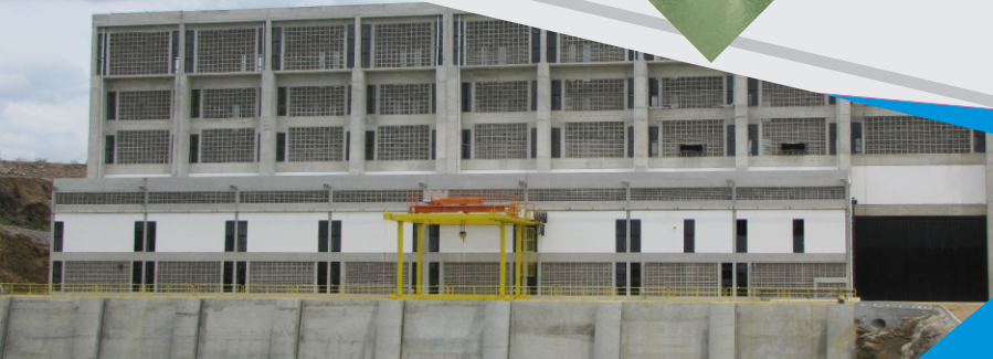
Estação de Bombeamento EBI-1
