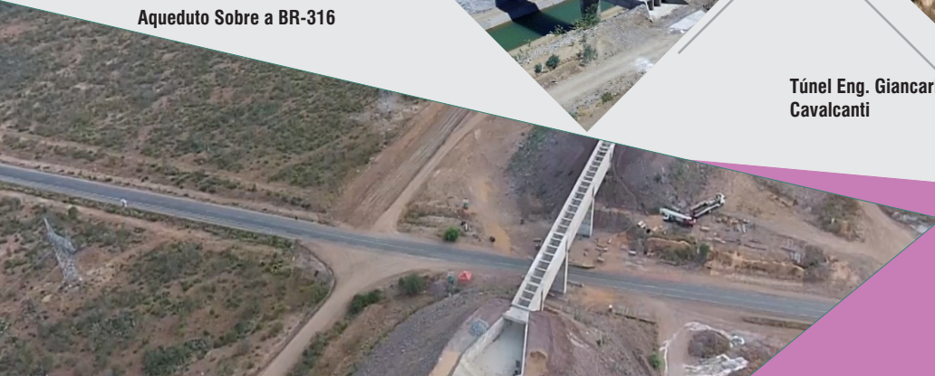
Aqueduto Sobre a BR-316
