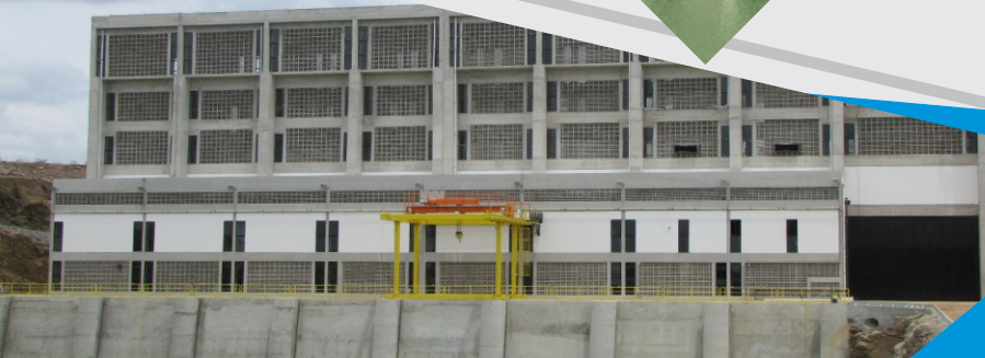
Estação de Bombeamento EBI-1
