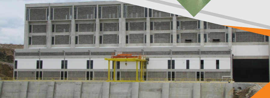
Estação de Bombeamento EBI-1
