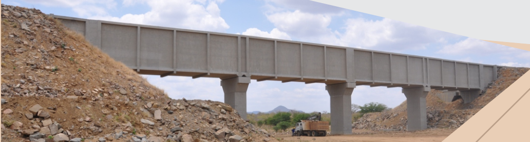
Aqueduto Sobre a BR-316
