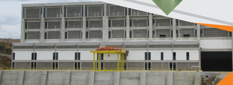
Estação de Bombeamento EBI-1
