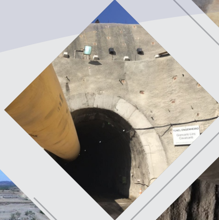
Túnel Eng. Giancarlo Lins Cavalcanti - Emboque
