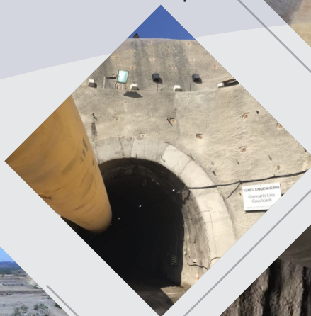
Túnel Eng. Giancarlo Lins Cavalcanti - Emboque
