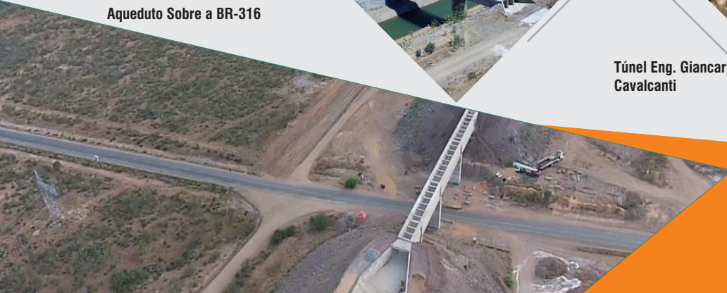
Aqueduto Sobre a BR-316
