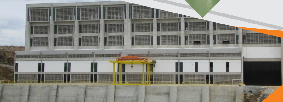
Estação de Bombeamento EBI-1
