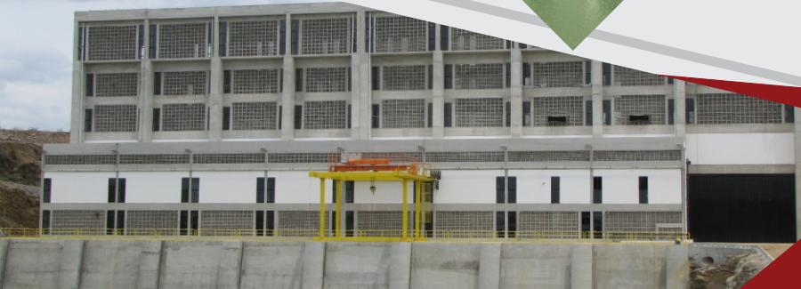
Estação de Bombeamento EBI-1
