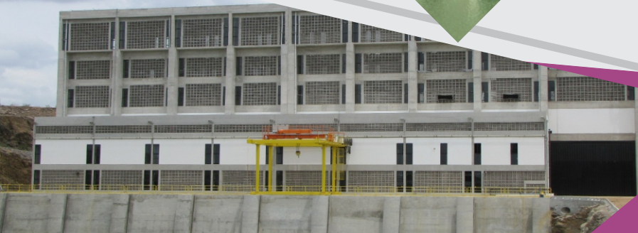
Estação de Bombeamento EBI-1
